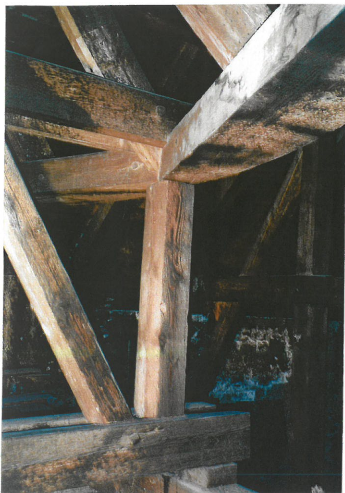
9. Szczegół koryta odwadniającego nad zniszczonym tramem.
