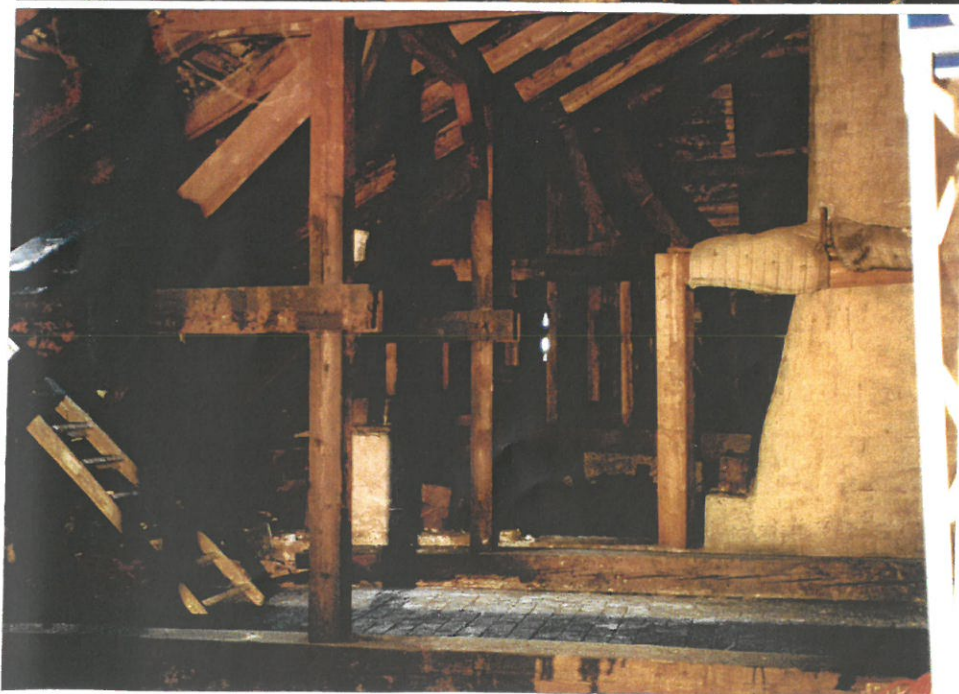
3. Widok ogólny więźby.
