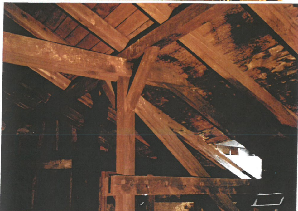
2. Widok ogólny więźby.
