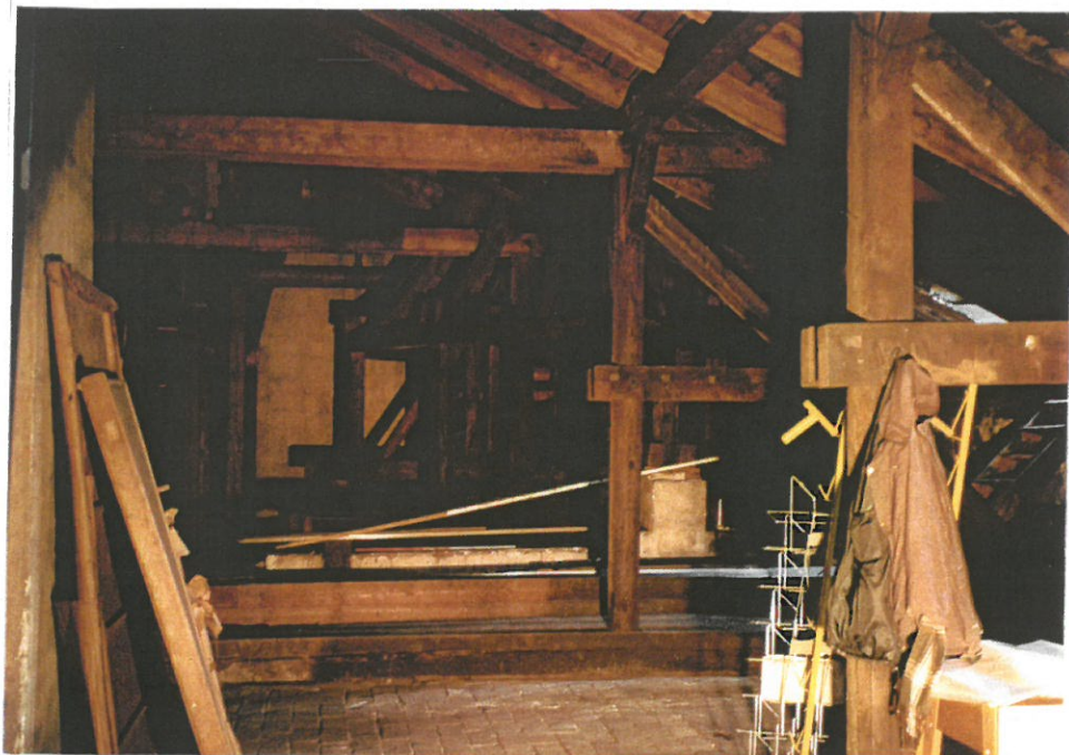
1. Widok ogólny więźby.
