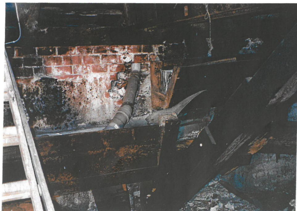
9. Szczegół koryta odwadniającego nad zniszczonym tramem.
