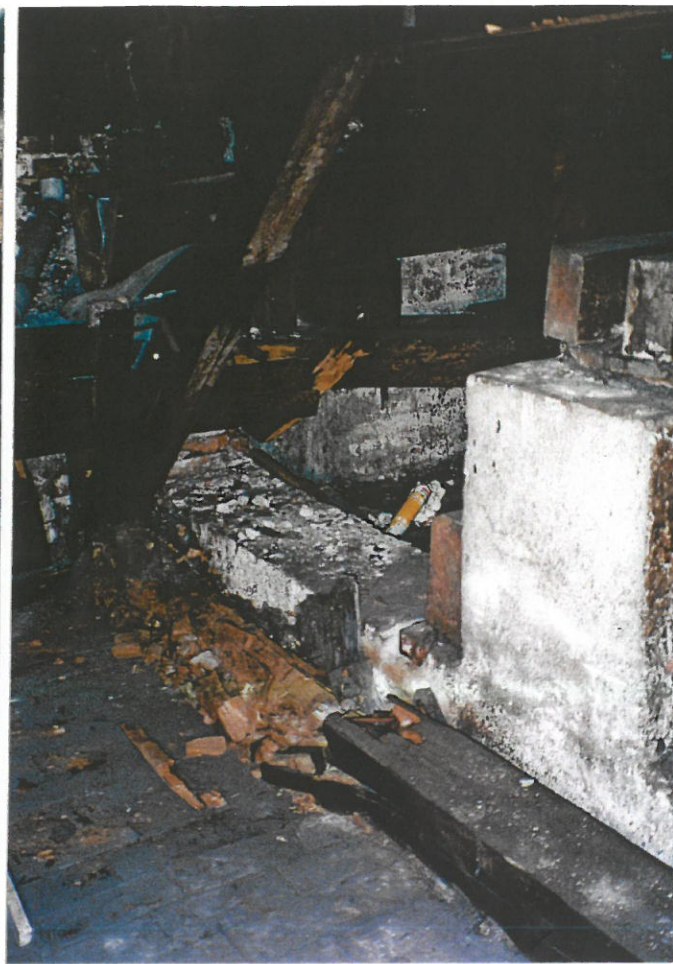
9. Szczegół koryta odwadniającego nad zniszczonym tramem.
